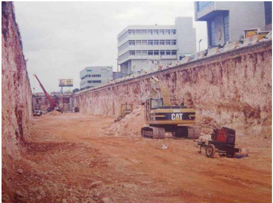
Figura 13. Construcción del túnel de la Av. 27 de febrero, uno de los “megaproyectos” del gobierno de Leonel Fernández 1996-200. Fuente: Imágenes de Nuestra Historia.
