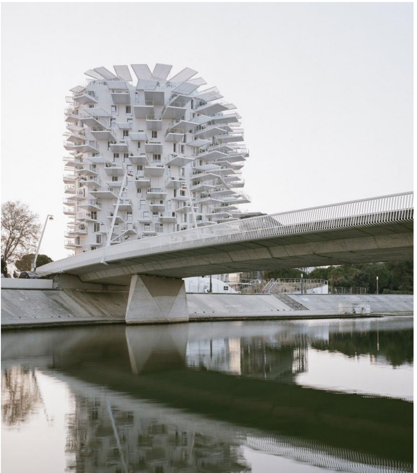
Figura 13: Árbol Blanco (L'Arbre Blanc) Arq. Sou Fujimoto, Architects, Nicolas Laisné Associés y Manal Rachdi Oxo Architects. Fuente: Pagina web Metalocus, Equipo liderado por Sou Fujimoto diseña torre de vivienda inspirada en árboles, para Montpellier.
