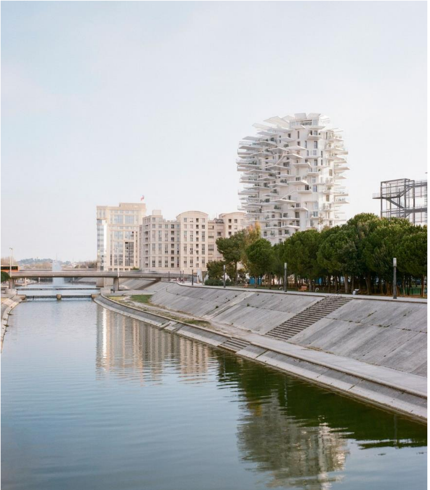
Figura 14: Árbol Blanco (L'Arbre Blanc) Arq. Sou Fujimoto, Architects, Nicolas Laisné Associés y Manal Rachdi Oxo Architects. Fuente: Pagina web Metalocus, Equipo liderado por Sou Fujimoto diseña torre de vivienda inspirada en árboles, para Montpellier.
