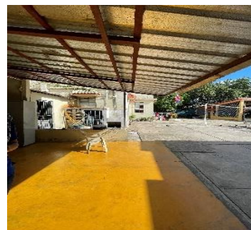
Fotografía 2. Patio. Fuente propia.
