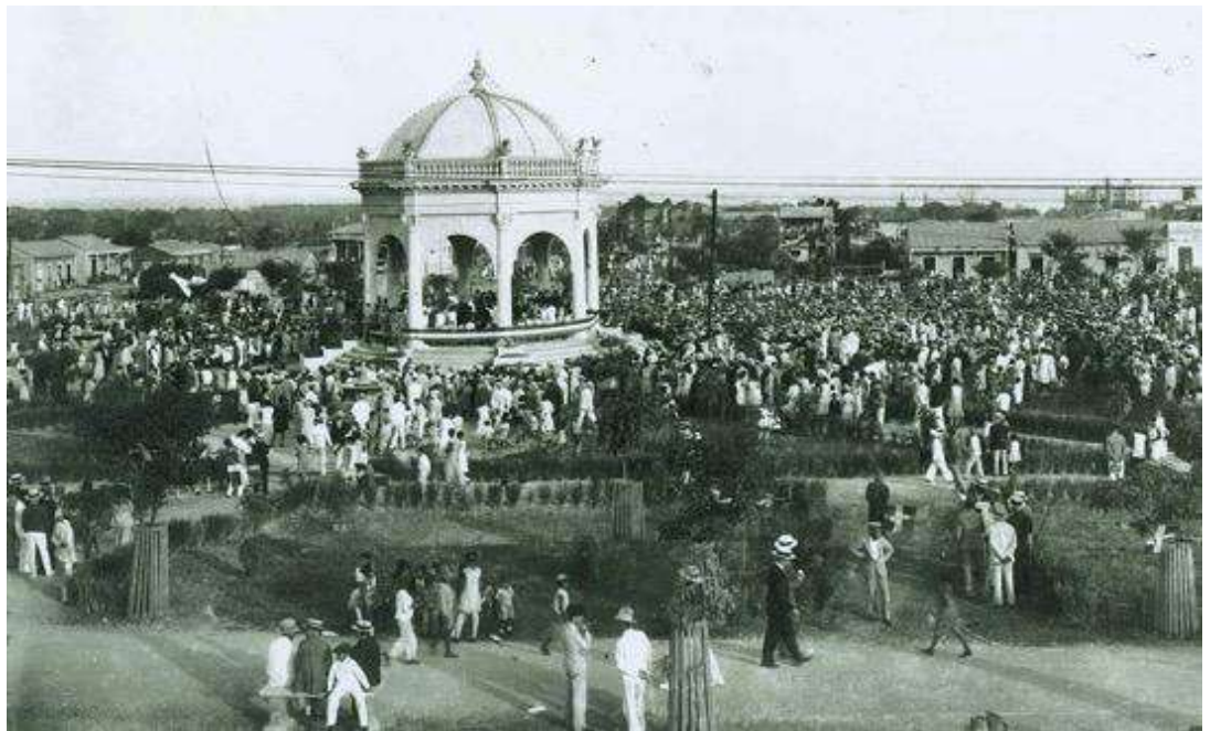
Figura 14. Inauguración del Parque Enriquillo en Villas Francésca en 1930 (desaparecida) al norte de la centro histórico Santo Domingo. Fuente: Archivo General de la Nación.
