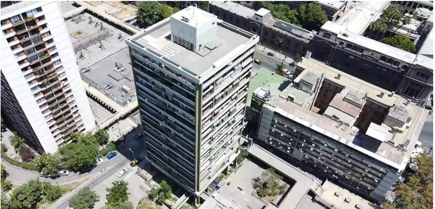
Figura 2: Torres Remodelación San Borja. Elaboración Propia.
