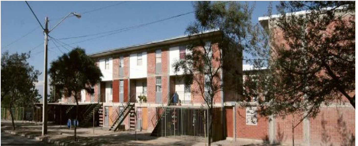
Figura 8: Conjunto Bloques Viviendas. Fuente: https://divisare.com/projects/280780-elemental-alejandra-aravena-lo-espejo
