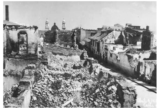
Foto 4 y 5. Destrucción de inmuebles Fuente: www.banrepcultural.org.
