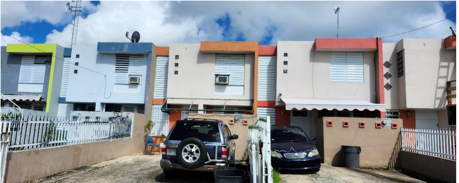
Figura 9. Villa Habitat en Cantera
