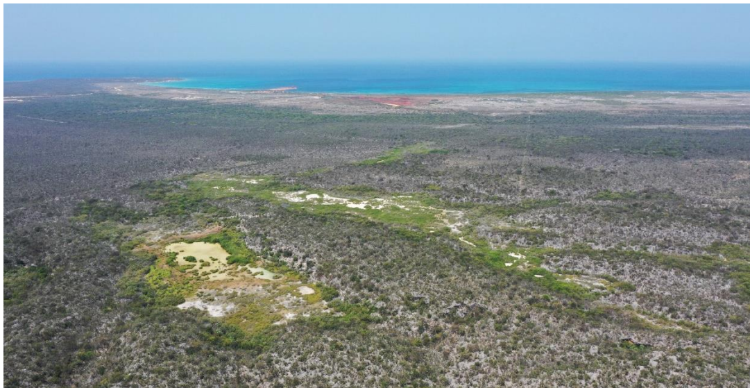
Figura 3. Zona de áreas protegidas dentro de los humedales de Cabo Rojo. ARQA, 2024.
