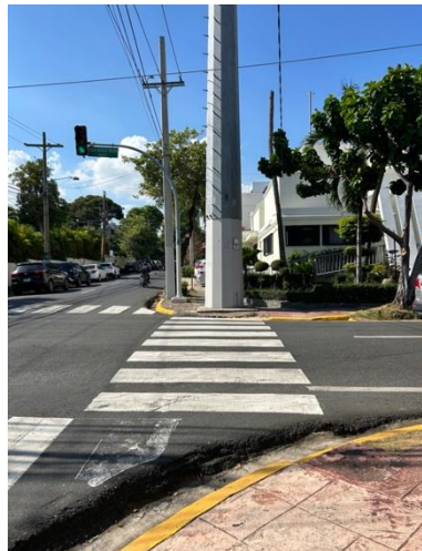
Figura 4. Torre de transmisión eléctrica colocada a continuación del cruce peatonal. Fotografía propia.
