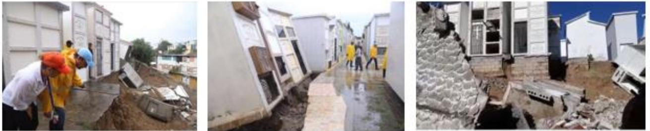
**Figura 11:** Deslizamientos de tierra y derrumbes de nichos en el Cementerio Municipal de la Calle 30 de Marzo luego del paso del Huracán María. Septiembre 2017. Fuentes: (Minalla, 2017)
