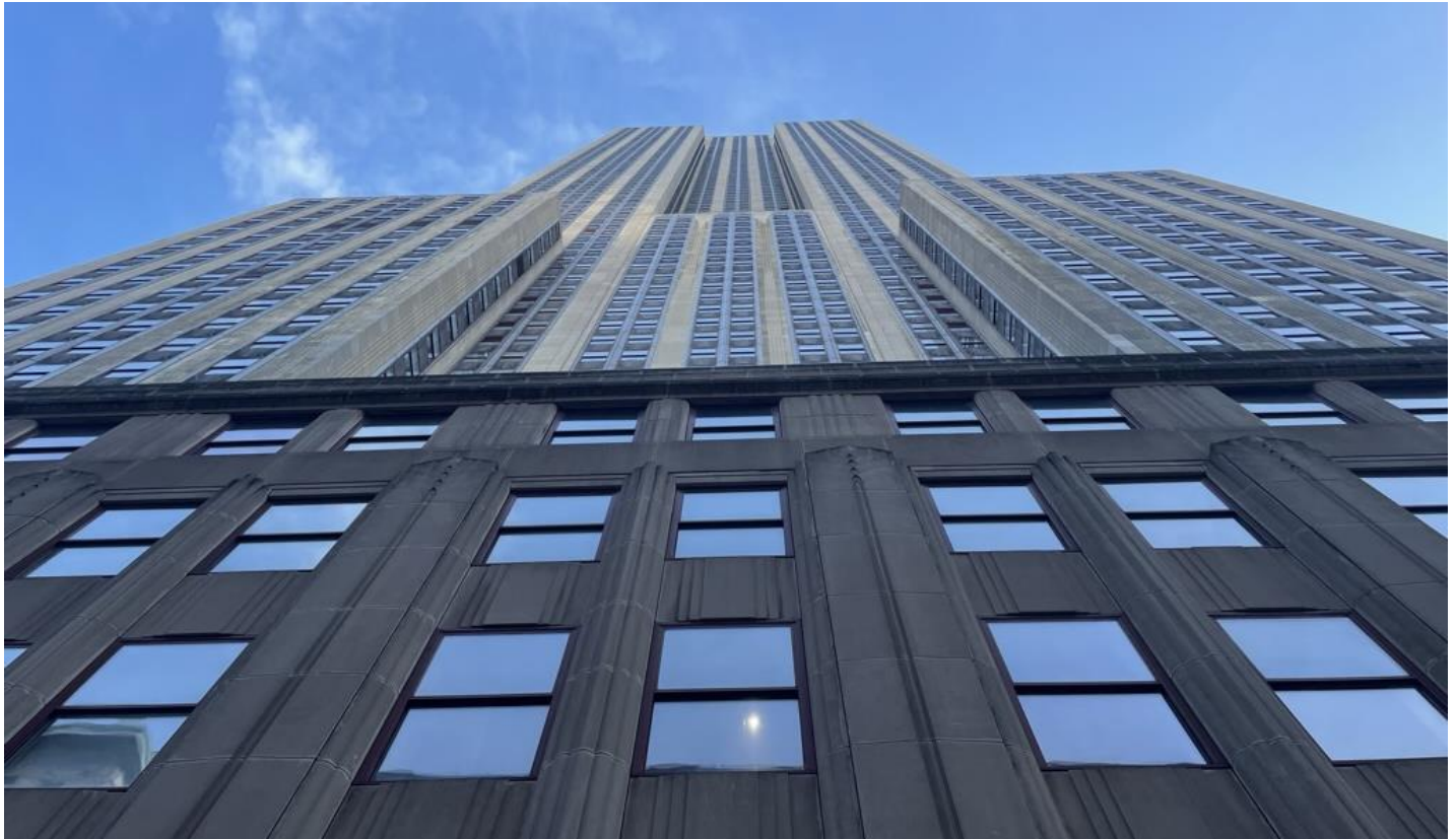
Figura 4. El Empire State Building inaugurado en 1931 en Nueva York fue uno de los primeros edificios en utilizar de modo extensivo el aluminio en la carpintería de las ventanas. Foto: Jorge Marte, 2022.
