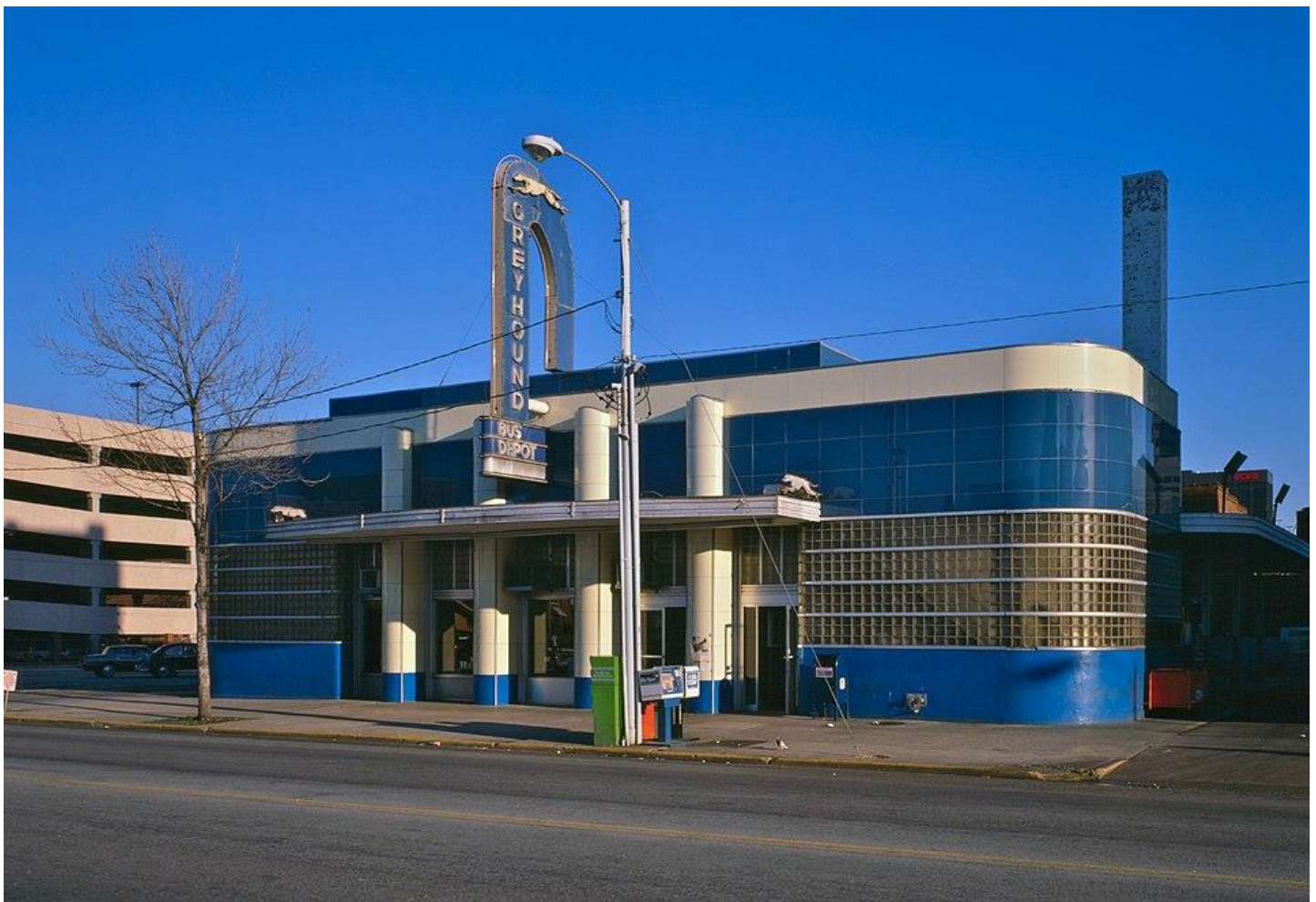
Figura 5. Estación de autobuses Greyhound (1938-39), Condado de Richland, Columbia, Carolina del Sur, EE. UU. Nótese el uso de paneles Vitrolite en la franja azul de la parte superior, bloques isotérmicos en la franja central y cartpintería de vidrio y aluminio en las puertas. Fuente: Wikimedia Commons.
