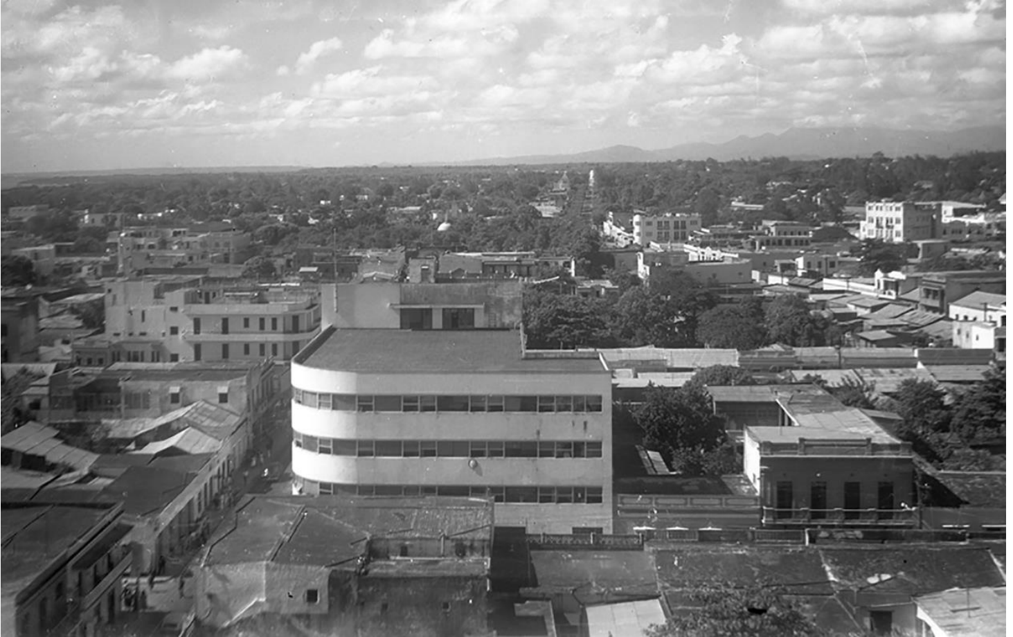
Figura 1. Vista aérea del Edificio Copello (c. 1940). Colección Luis Mañón. Fuente: Archivo General de la Nación.
