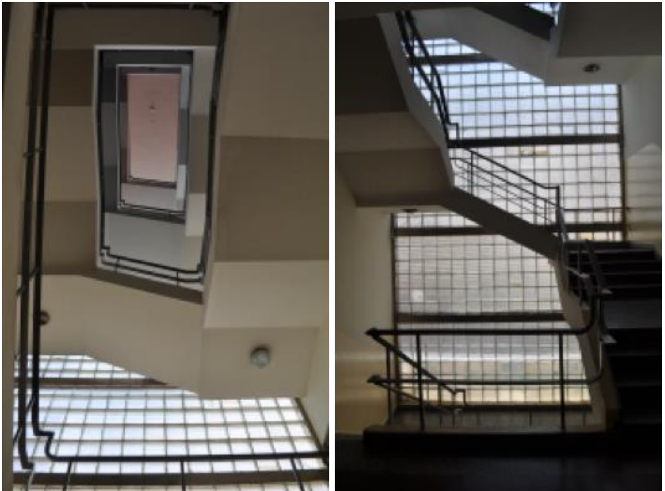
Figura 13. Vistas interiores de la escalera y el muro cortina de bloques isotérmicos de vidrio en el Edificio Copello. Fotos: Jorge Marte (2010)
