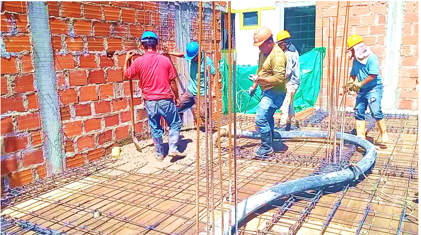
Figura 1. Construcción vivienda VIS, Floridablanca, Santander (Colombia). Fuente: Elaboración propia (2024).
